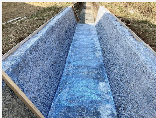
プライマー塗布
